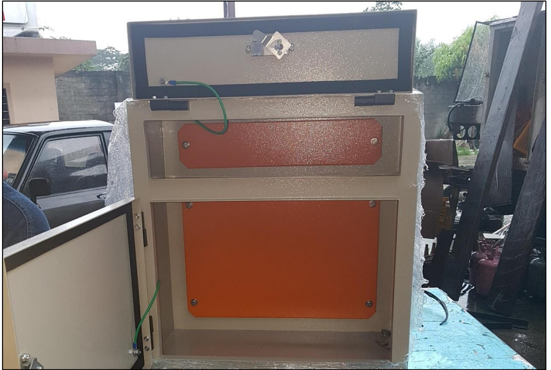
Anexo 5. Fondo falso (plafón) del tablero Elaborado por: Autor
