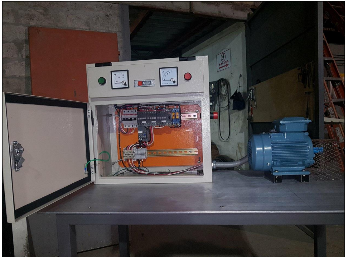
Anexo 35. Colocación del acrílico protector. Elaborado por: Autor
