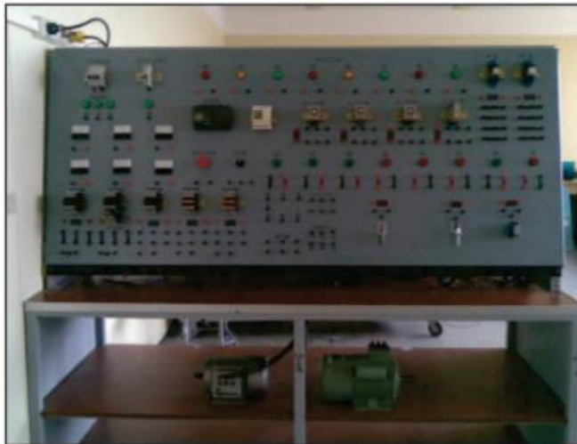
Figura 2.1: Consola de control para motores en laboratorio. Fuente: (Guanín, R. 2009)
