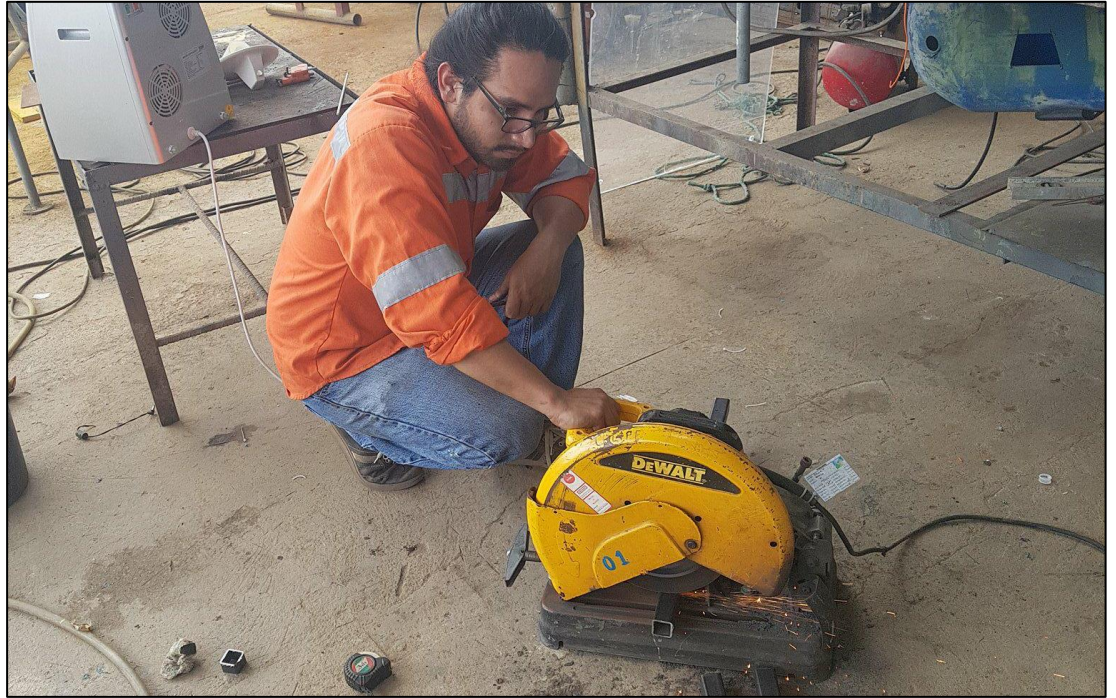
Anexo 15. Corte con amoladora para la base del motor Elaborado por: Autor
