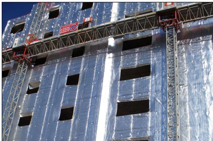
Figura 3.1: Edificio con envolvente de material reflexivo. Fuente: (Arelux, 2017)
