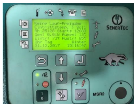
Figura 3.43. Panel de control Fuente: (Jiménez, 2016)
