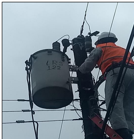
Figura. 8.1 Extracción de aceite de un transformador. Fuente: ("CNEL EP LRS", 2017)
