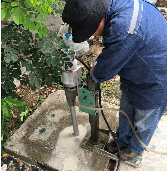
Figura 28: Trabajador experto realizando perforaciones
