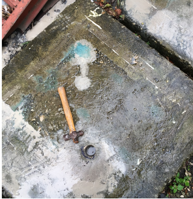
Figura 43: Orificio para el segundo ánodo. En el otro extremo se puede observar la marca de la instalación del primer ánodo
