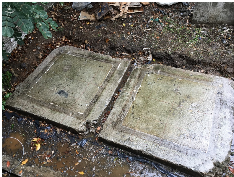
Figura 23: Estado de losetas al momento de retirar los marcos que mantenían agua sobre ellas
