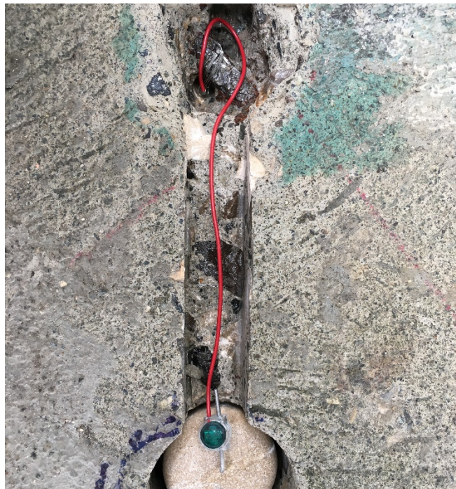
Figura 40: Conexión entre el ánodo y el acero de refuerzo
