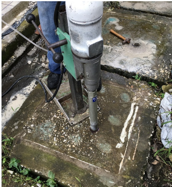
Figura 42: Perforación por segunda vez en cada una de las losetas
