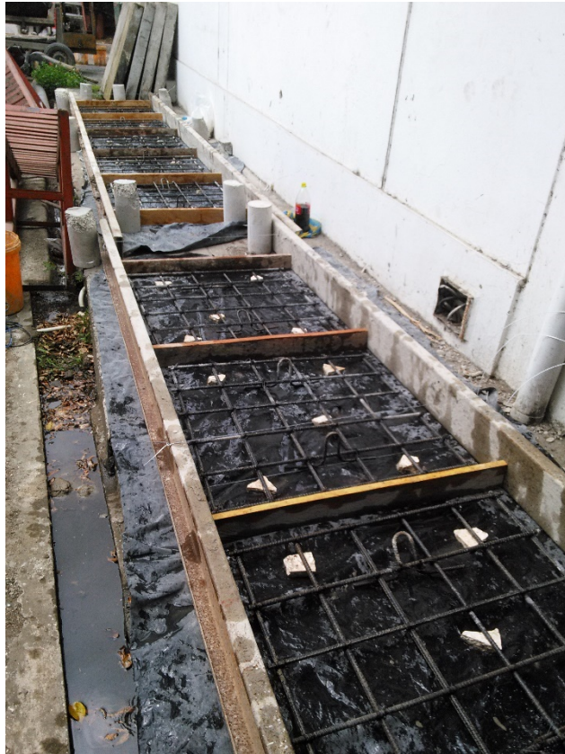
Figura 46: Encofrado para las nuevas losetas
