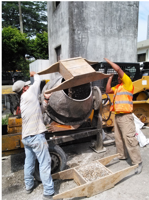
Figura 48: Fabricación del hormigón
