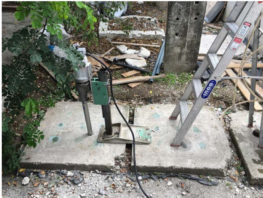
Figura 26: Taladro especial utilizado para realizar perforaciones en las losetas
