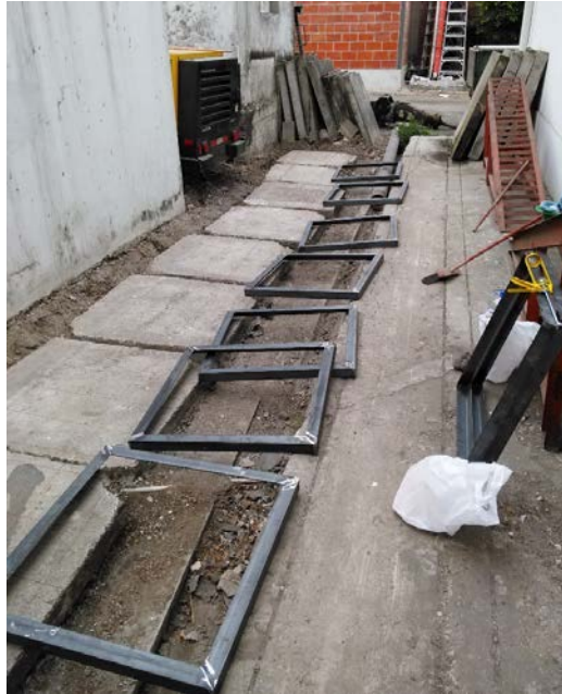
Figura 20: Marcos listos para ser adheridos a las losetas
