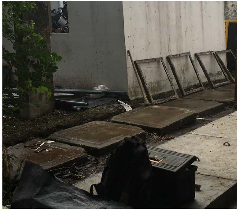
Figura 22: Marcos removidos de losetas
