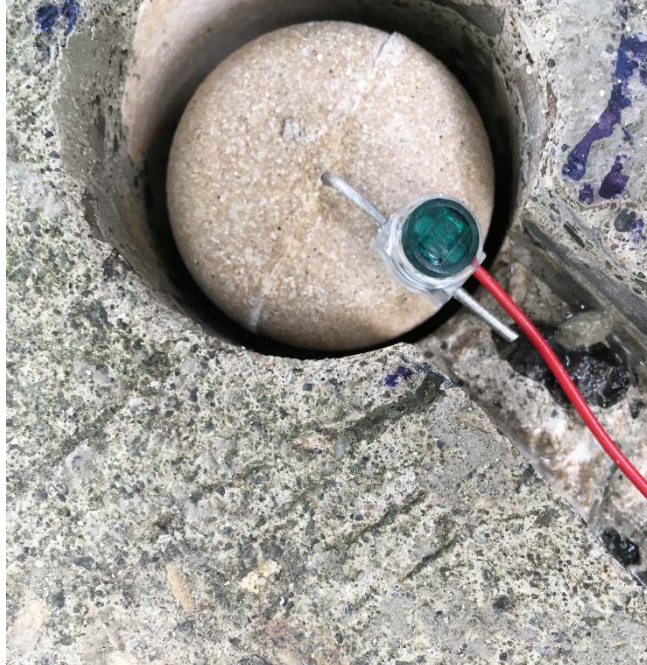
Figura 39: Cable de Cobre unido al ánodo mediante un conector
