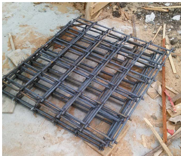
Figura 45: Armadura utilizada en nuevas losetas
