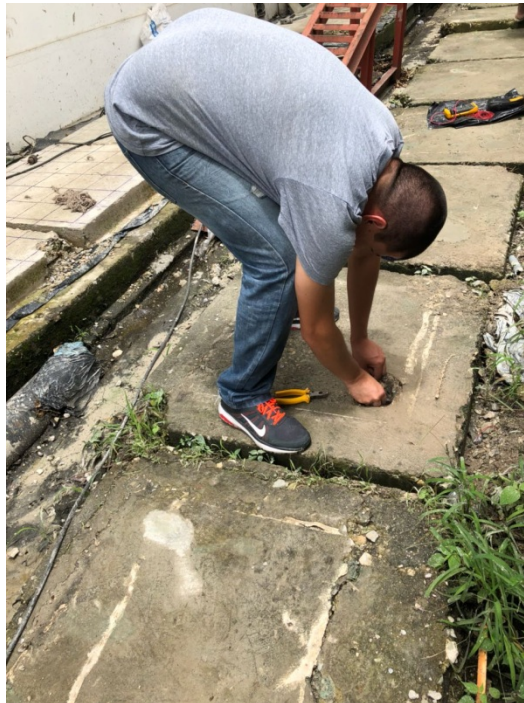
Figura 44: Instalación del segundo ánodo
