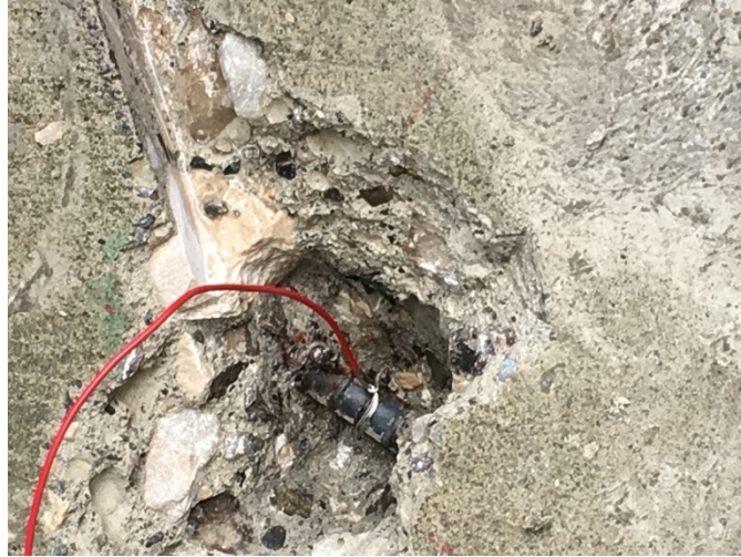
Figura 35: Conexión al acero de refuerzo mediante un cable de Cobre que irá conectado en el otro extremo al ánodo
