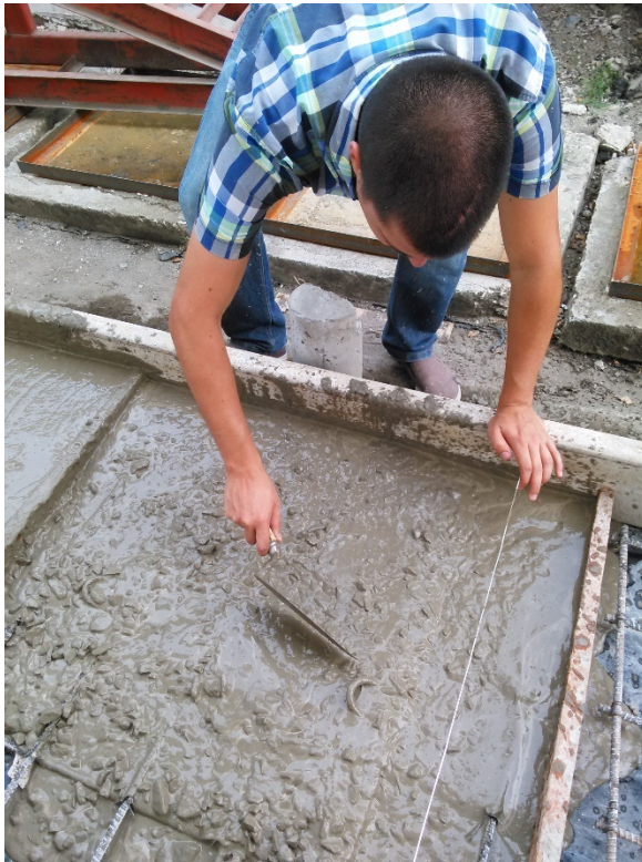
Figura 49: Fundición de nuevas losetas
