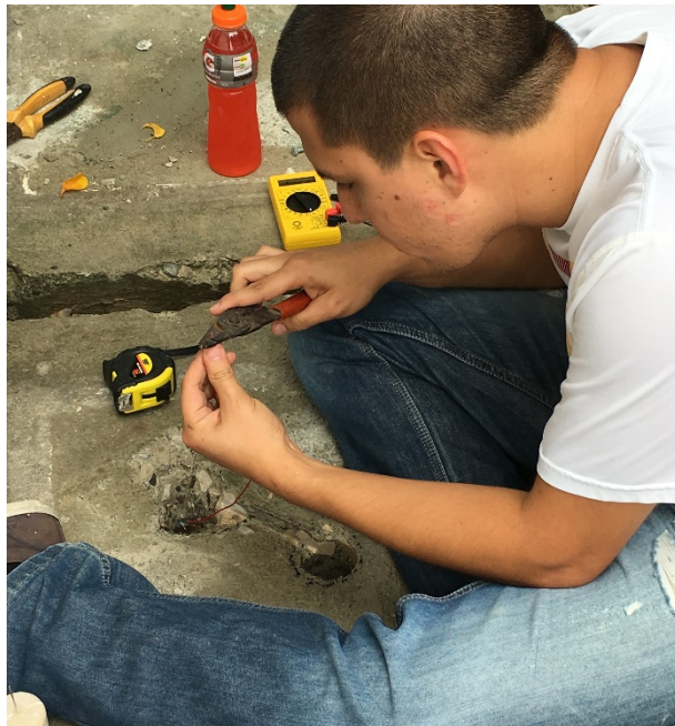
Figura 38: Conectando el cable desde el ánodo hacia el acero de refuerzo
