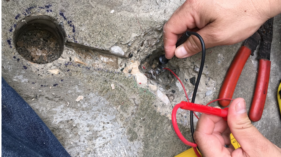
Figura 37: Comprobando flujo eléctrico entre cable y acero de refuerzo con ayuda de un multímetro
