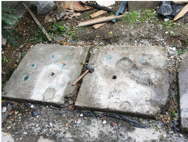
Figura 29: Perforaciones en losetas
