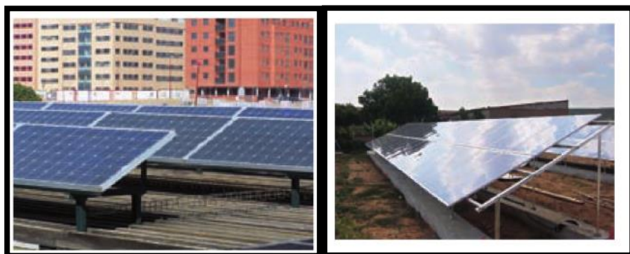
Figura 2.16: Estructura Fijas De Los Paneles Fotovoltaicos Fuente:(Roldán & Viloría, 2008, p. 177).
