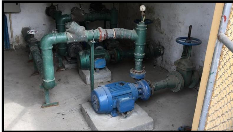
Ilustración 17. Bombas propulsoras del agua tratada.
