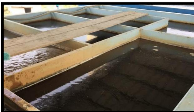
Ilustración 10. Unidad de coagulación y floculación
