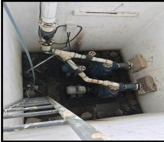
Ilustración 7. Bomba de succión para la planta INTAL.
