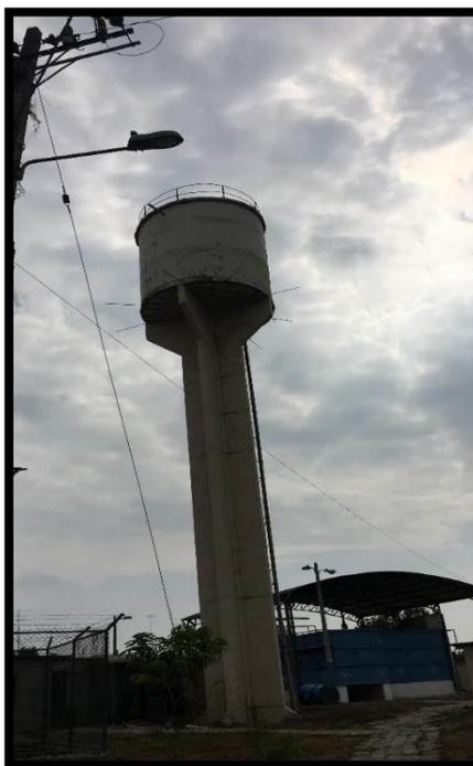
Ilustración 16. Tanque elevado de hormigón armado.
