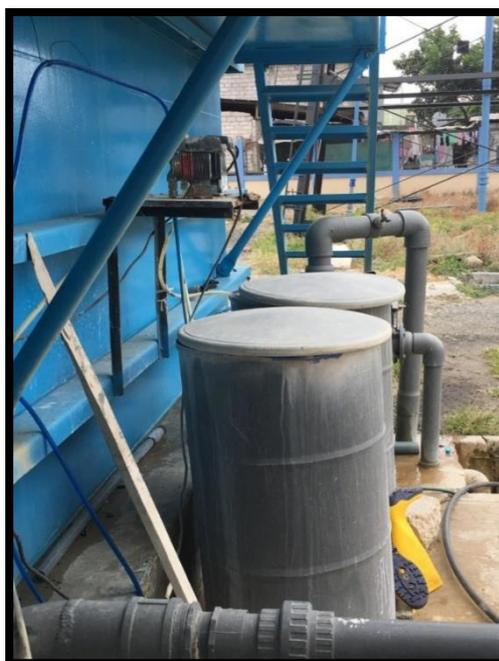
Ilustración 12. Bombas dosificadoras automáticas para la planta UPA.
