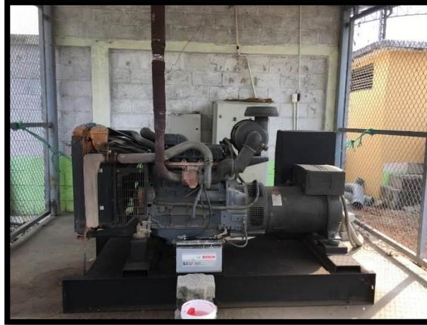
Ilustración 18. Generador de energía para casos de emergencia.
