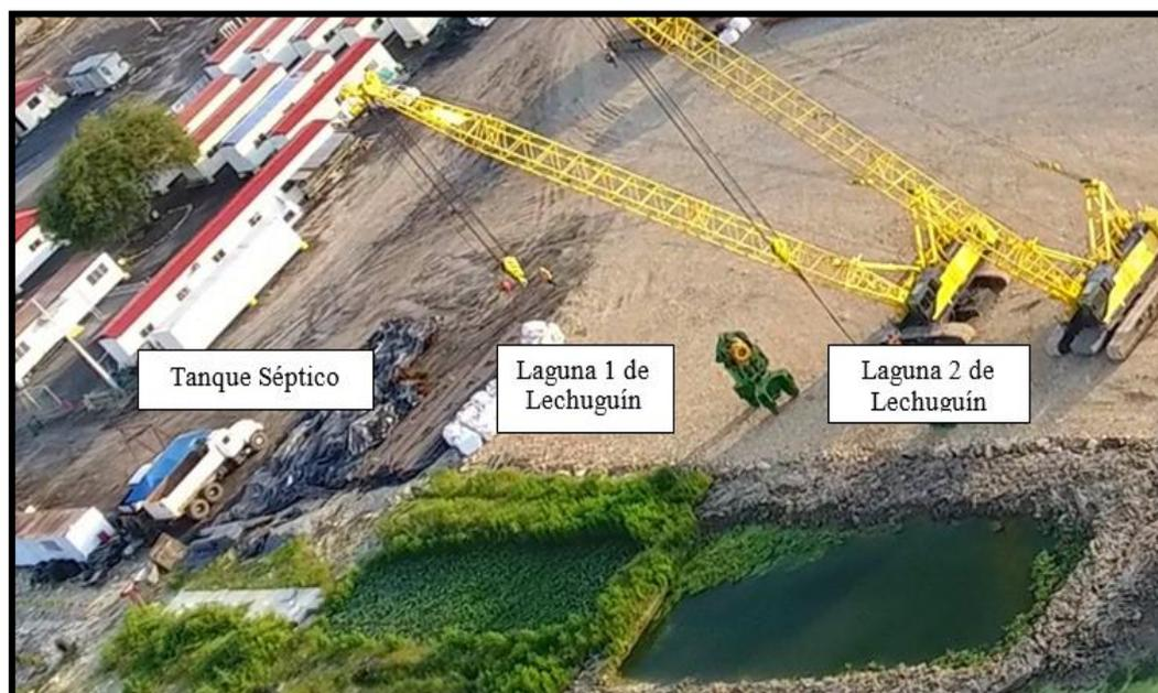
**Ilustración 22** Vista aérea de la Planta de tratamiento de Aguas Residuales Domésticas del Campamento Ptar- Las Esclusas en donde se puede observar el Tanque Séptico, la Laguna 1 de Lechuga de Agua en donde se refleja que se encuentra totalmente cubierta su superficie de esta planta y la Laguna 2 de Lechuga de Agua que se encuentra parcialmente cubierta.
