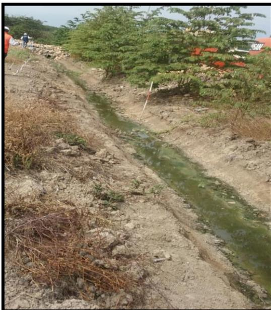
**Ilustración 21 Canal de 110 m de longitud que conduce el agua tratada del sistema de tratamiento del campamento Ptar- Las Esclusas y finalmente se descarga al Estero Cobina.**
