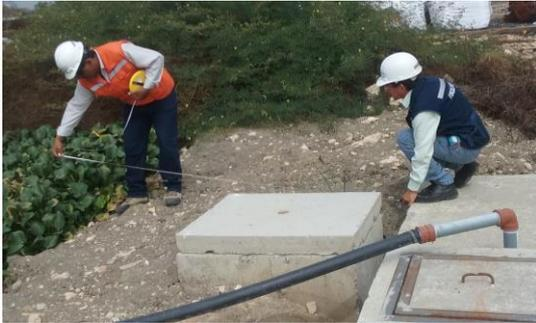
**Fotografía 26 Medición en campo del Tanque Séptico y sus siguientes procesos.**
