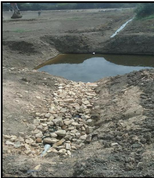
**Ilustración 20 Filtro de piedra caliza en el cual el efluente se almacena en una laguna de maduración cuadrangular.**
