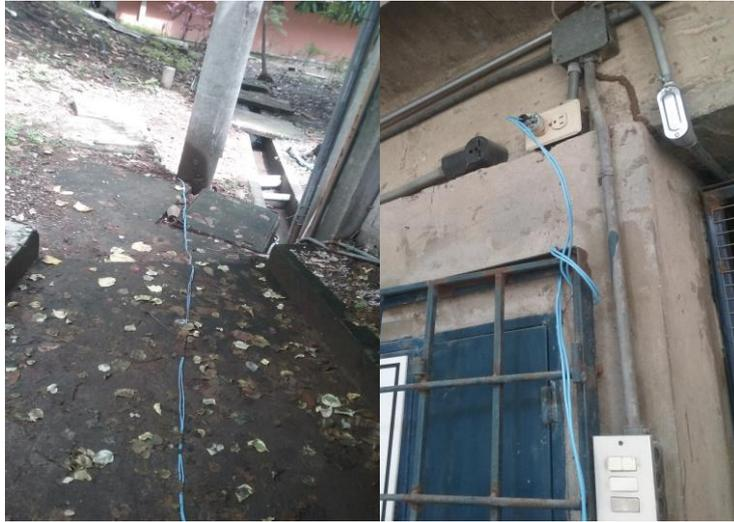
**Fotografía 78 Conexión de la bomba de succión ubicada en la periferia de la alcantarilla en donde se recolecta el AARRDD.**
