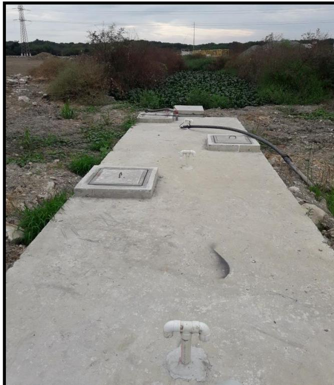
**Ilustración 17 Tanque Séptico al cual le llega el AARRDD cruda del campamento Ptar Las Esclusas.**
