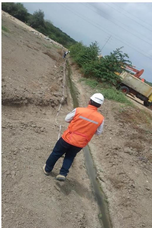
**Fotografía 30 Canal de 110 m de longitud que descarga directamente al Estero Cobina.**
