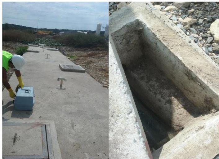
**Fotografía 5 Identificando la alcantarilla en donde llega el agua residual doméstica cruda antes que ingrese al Tanque Séptico**
