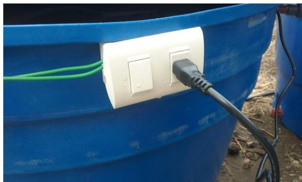
**Fotografía 86 Switch eléctrico de la Segunda bomba que se encuentra en el tanque homogeneizador.**
