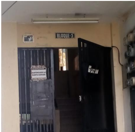
Fotografía 33. Bloque 3 del sector La Primavera.
