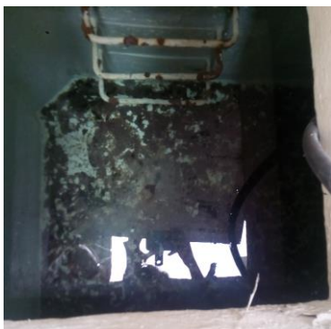
Fotografía 73. Cisterna del Bloque 4-A.
