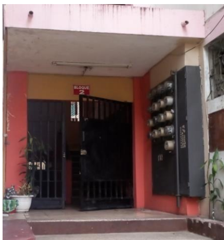
Fotografía 39. Bloque 2 del sector La Primavera.
