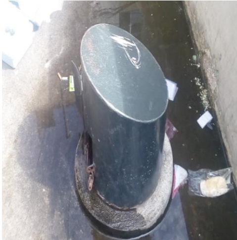
Fotografía 1. Cantidad de Cloro antes de la cisterna del Bloque C7.
