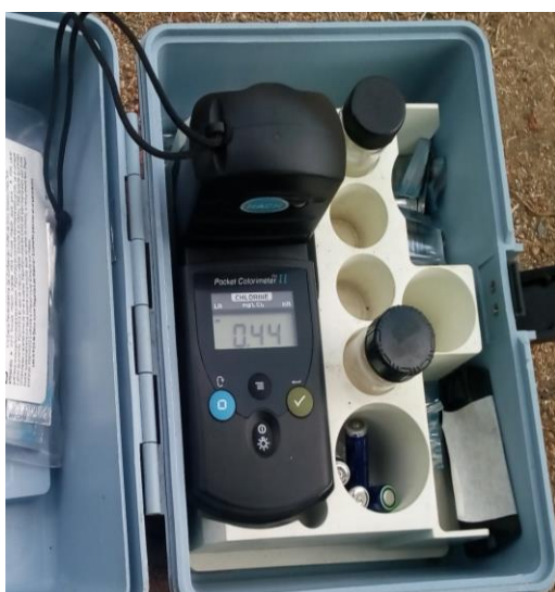
Fotografía 29. Cantidad de Cloro que ingresa a la Cisterna del Bloque C1.
