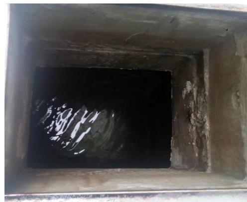
Fotografía 16. Cisterna del Bloque A5.
