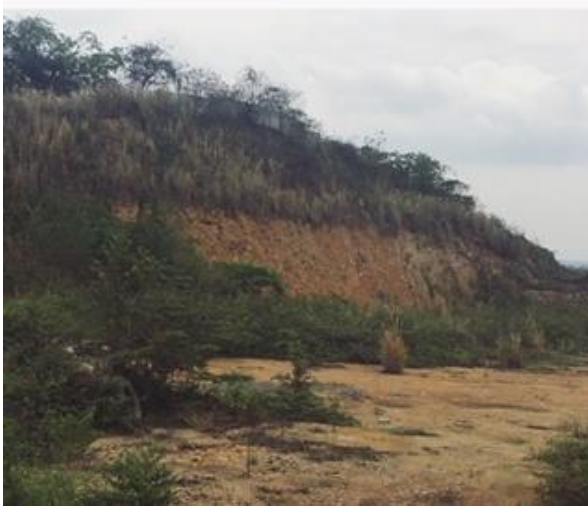
Ilustración N° 11 - Formación del Cayo se observa en el área del Proyecto en la vía Perimetral.
