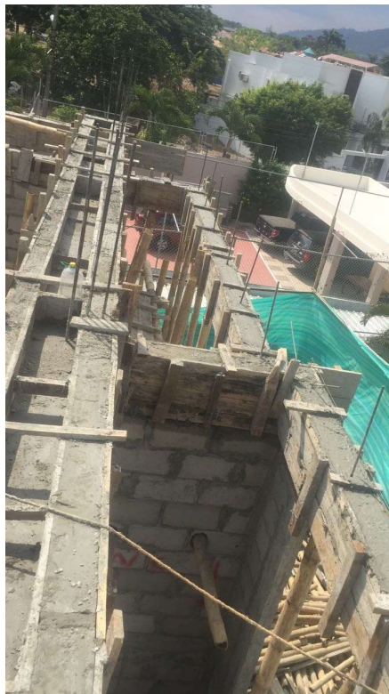
Ilustración 56: Hormigonado de vigas de cubierta
