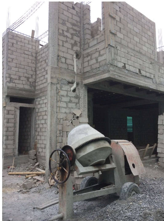
Ilustración 54: Concretera usada para la preparación de hormigón, de vigas de cubierta
