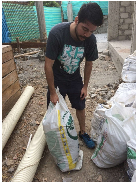
Ilustración 52: Pesado de los residuos de bloques de hormigón con la balanza
