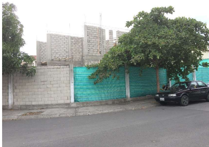
Ilustración 34: Vista frontal construcción vivienda Puerto Azul
