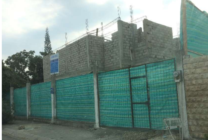
Ilustración 33: Vista lateral construcción vivienda Puerto Azul
