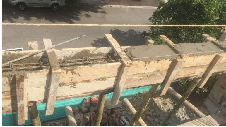
Ilustración 55: Vigas de cubierta de hormigón
