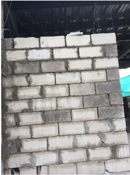
Ilustración 49: Paredes de bloques de hormigón
