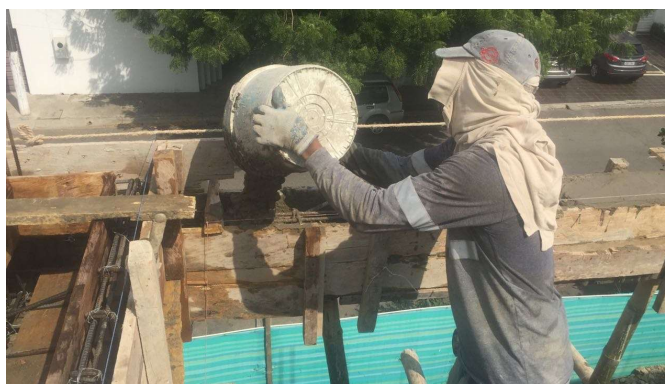
Ilustración 44: Vertido del hormigón para vigas de cubierta
