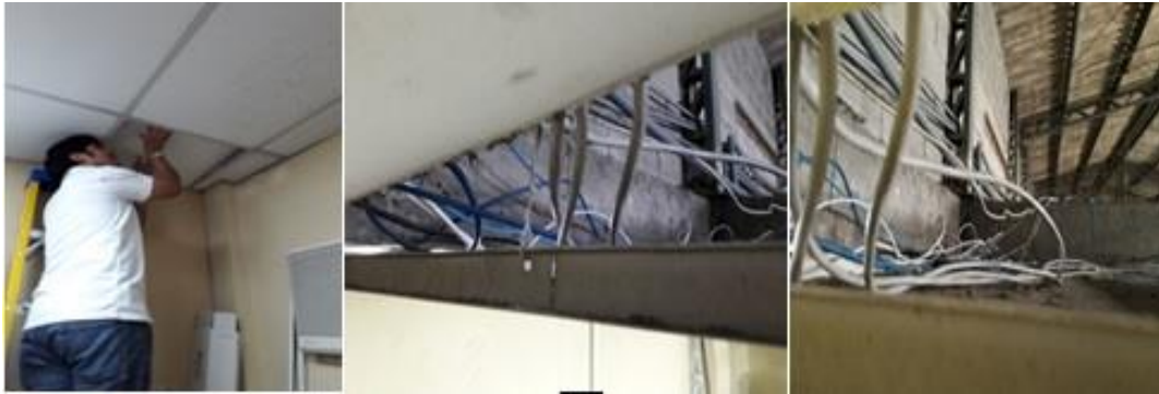
Figura 16. Cableado Horizontal del Hospital León Becerra de Guayaquil
