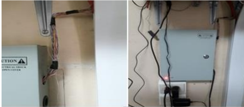
Figura 14. Sistema de Alimentación del CCTV del Hospital León Becerra de Guayaquil
