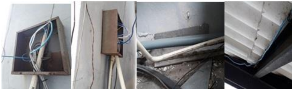
Figura 17. Cableado externo del Hospital León Becerra de Guayaquil
